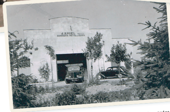
L'ancienne usine, dans les années 50
